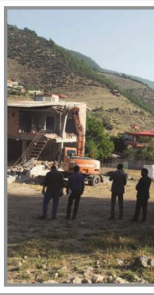
پروژه احداث راه دسترسی شهیدیه به ساحل دریا در حال اجراست.
