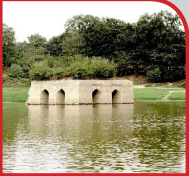
پل تاریخی دریاچه ولشت چالوس
